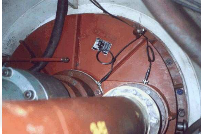
Implantation des capteurs sur le multiplicateur d'un groupe en puit ESAC (S.H.E.M.A).
